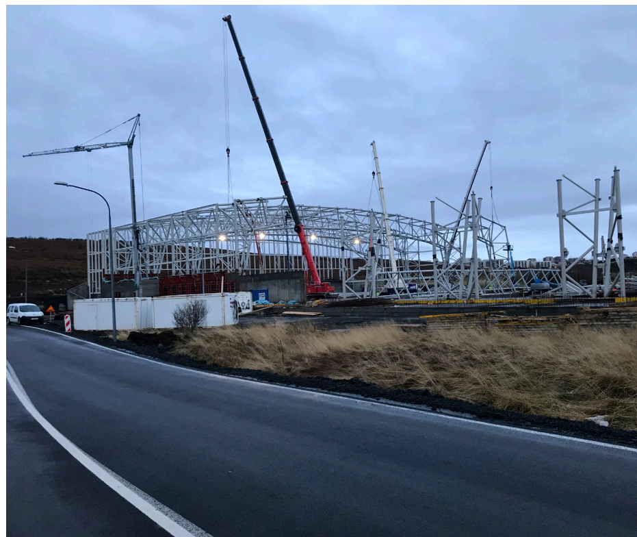
fjölnota íþróttahús í byggingu skv. eldra skipulagi
